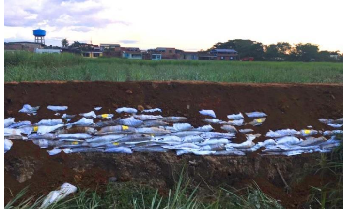
Ilustración 29. Obra provisional – Reparación dique Inundación La Virginia
